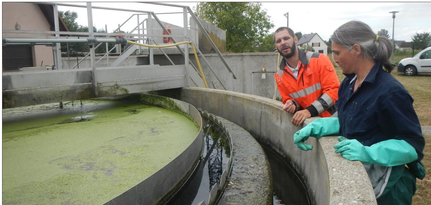
Les boues de la station d'épuration sont acheminées vers des bacs en béton plantés de roseaux.
