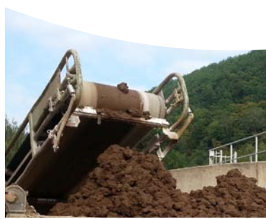
Boues déshydratées chaulées
