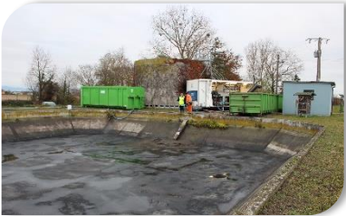
Visite du chantier de curage de la lagune de Rumersheim le haut.
