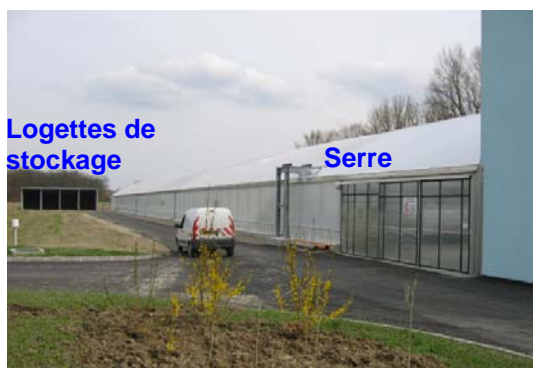
La serre de Biesheim mesure 100 m sur 12. Au fond, l'aire de stockage a une capacité d'un an (une logette par trimestre).
