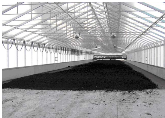
Serre de séchage solaire.
