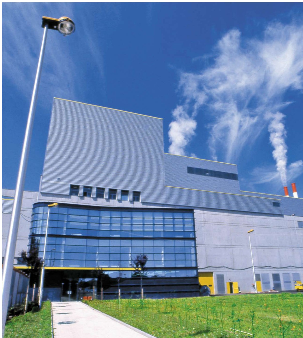
L'incinérateur de Sausheim.
