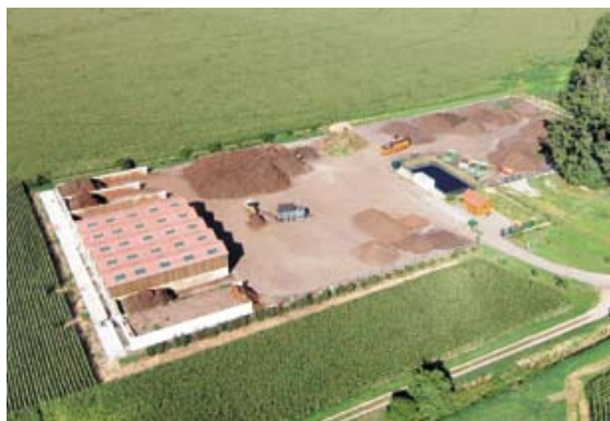
Plateforme de compostage de Bergheim.
