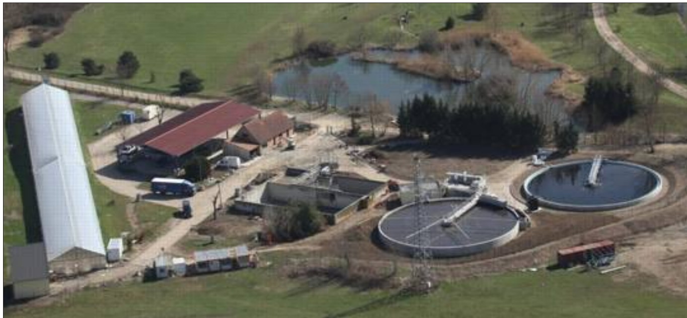
La nouvelle station d'épuration d'Ensisheim est opérationnelle depuis septembre dernier.
